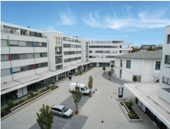
Innenhof des Gloria Palais mit Parkplätzen
